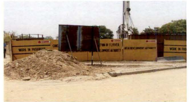
खेल गाँव के समीप फ्लाईओवर का निर्माण
