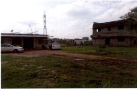
पीएचसी बोदसारा के आस-पास में निर्माणाधीन एसएचसी, बोदसारा छत्तीसगढ़ में अपूर्ण पड़ा रहा
