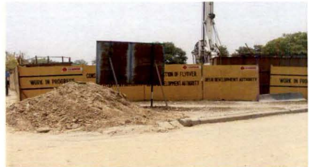
खेल गाँव के समीप फ्लाईओवर का निर्माण
