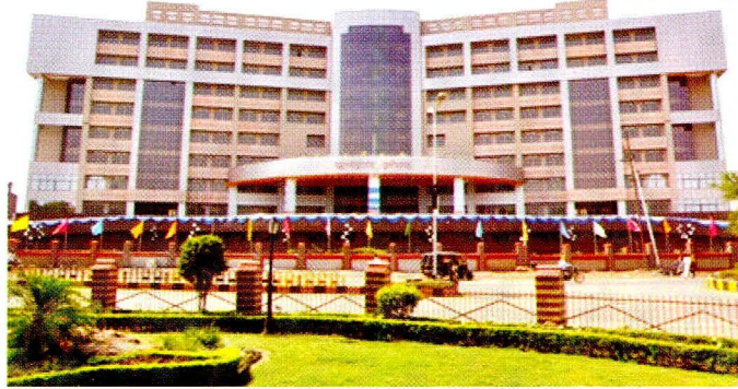
रायपुर में महालेखाकार कार्यालय भवन
