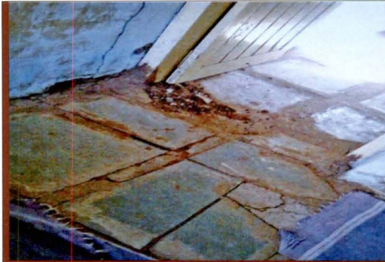
प्रदर्शन 4.7 गुजरात में एक आं.के. भवन में फर्श की खराब स्थिति
