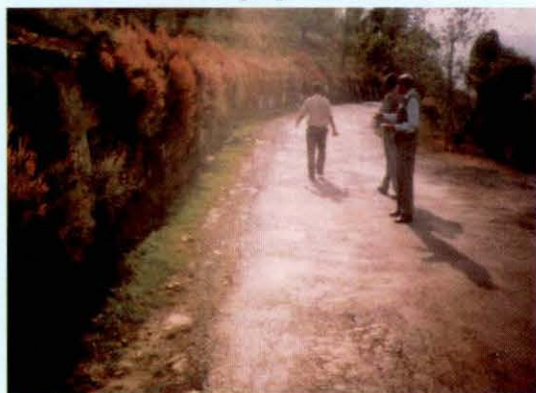
Chailla-Chopal road (km 12/810)
