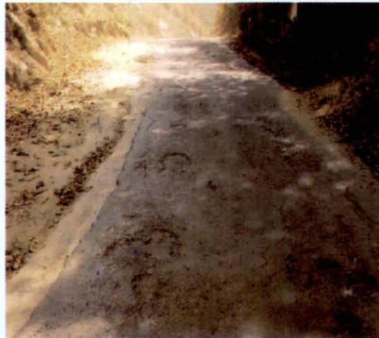
Dehra-Jawali road (km 16/405)
