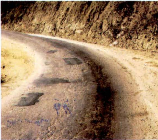
Dehra-Jawali Road (km 15/150)
