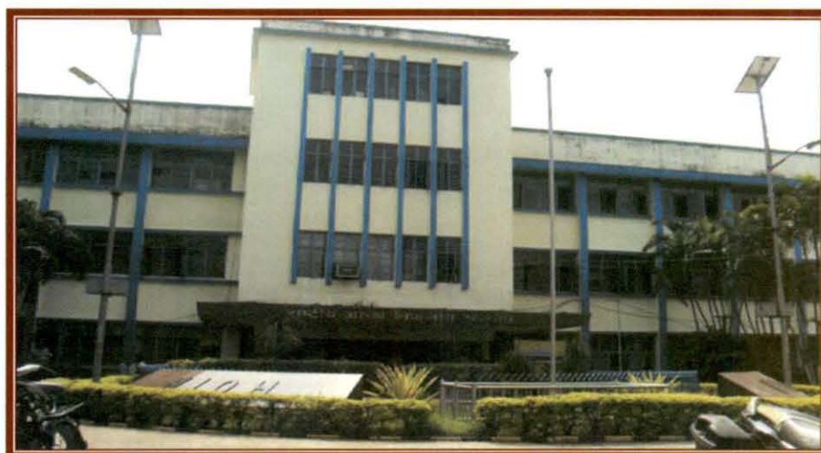
बीटी रोड़ बोन हुगली, कोलकाता में रा.वि.सं. के भवन का सामने का दृश्य
