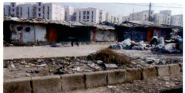
उत्तरी अंचल: सैक्टर जी-7 एवं जी-8 में पेरिफैरल एस.डब्ल्यू. ड्रेन एवं कलवर्ट का निर्माण
