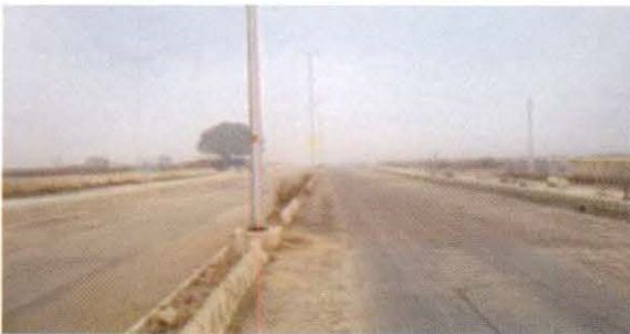
रोहिणी अंचल: मुख्य कैरिजवे का निर्माण
