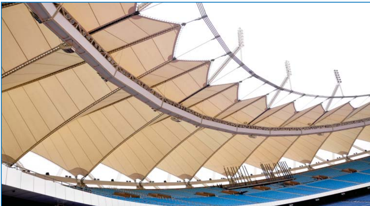
Tensile membrane roof over JNS
