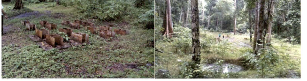
चिड़ियाटापू बायलाजीकल पार्क में सीडब्ल्यू के निर्माण की वर्तमान स्थिति
