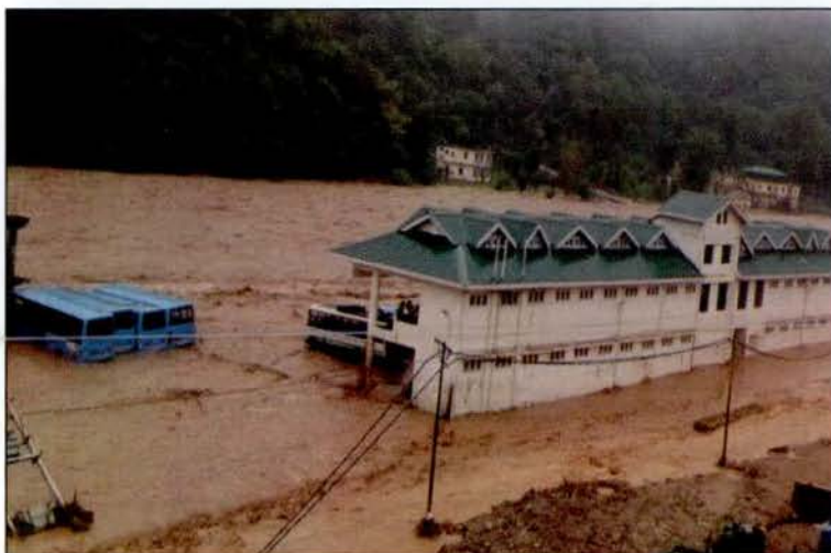
बाढ़ सुरक्षा उपायों के बिना खड्ड के साथ बस अड्डे का निर्माण करने के परिणामस्वरूप 07-08 अगस्त 2015 की मध्य रात्रि में अचानक आई बाढ़ के कारण धर्मपुर बस अड्डे एवं बसों की क्षति को दर्शाता छायाचित्र
