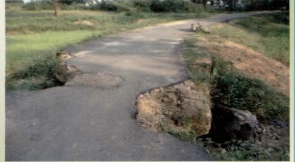
झारखंड के सिमडेगा जिला, में पंडरीपानी जलडेगा से पंडरीपानी तक सड़क की क्षतिग्रस्त पुलियां
