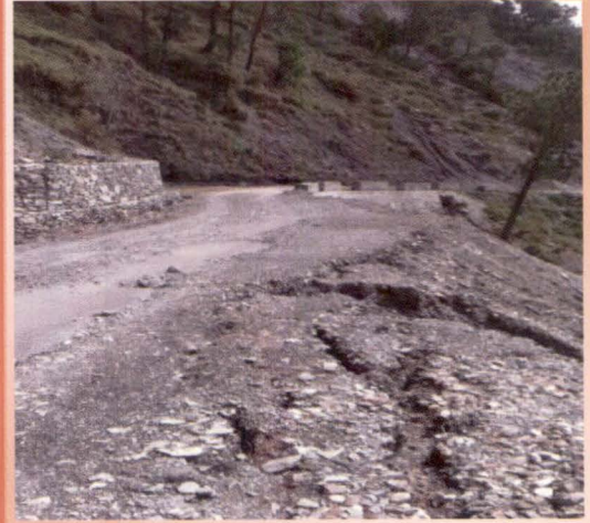
हिमाचल प्रदेश के कांगड़ा जिला, में बिना खडंजे तथा प्लस्टर न की गई रूमहर-लाम सड़क
